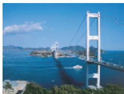
① 来島海峡大橋
